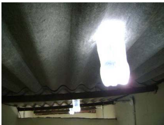
Garrafa pet para iluminação de residências de baixa renda
